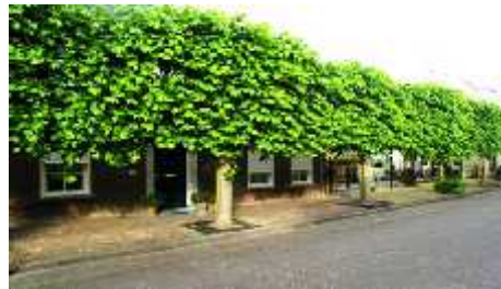
Bepanting zorgt voor schaduw in zomer, gebouw warmt minder snel op.
